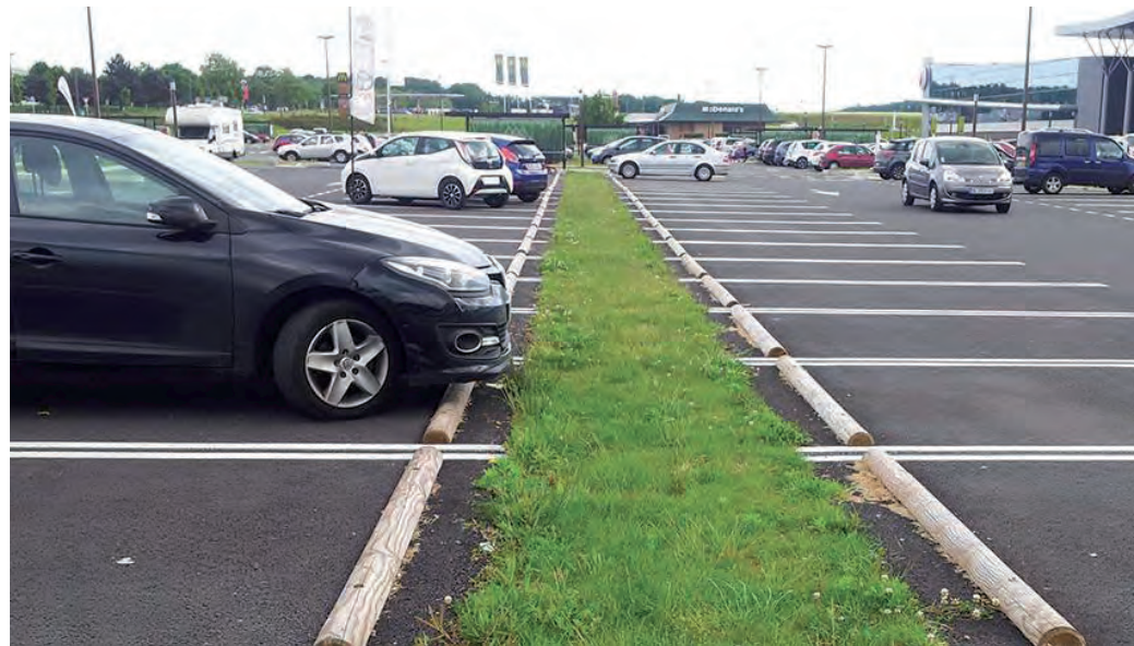
Aire de stationnement d'un hypermarché avec des noues enherbées de faible largeur
