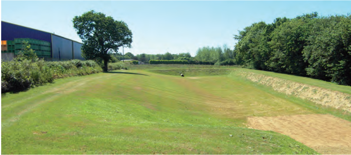
Bassin de rétention végétalisé Parc d'activités de Kerantour Laure Planchais paysagiste
